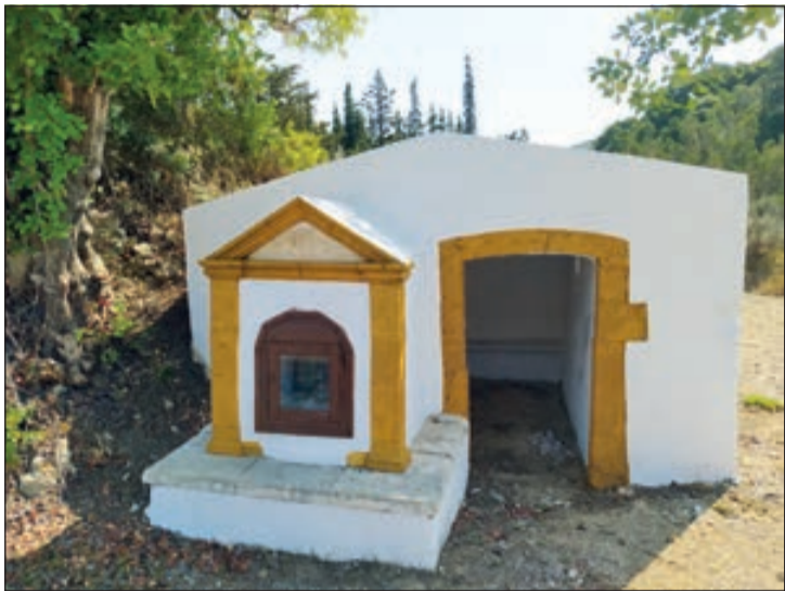
Το περίπτερο - αναπαυτήριο- εικονοστάσι στον κεντρικό δρόμο στην περιοχή Κακημέλιστα. Στην πάνω φωτογραφία η αψίδα του εικονοστασίου με την επιγραφή.
