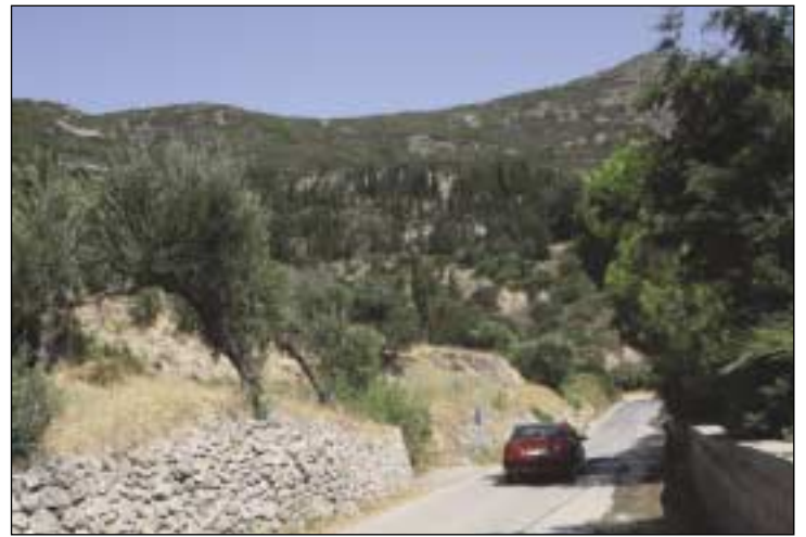
Πέντε φορές έσπασε ο αγωγός στο Μανιτοχώρι...
